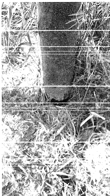
Figura 2 – Vários postes de iluminação com ferrugem.
