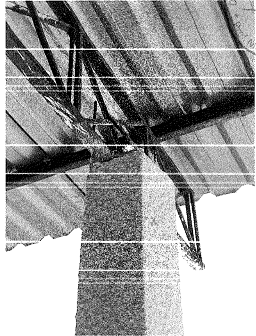
Figura 15 – Pilar com amarração inadequada.
