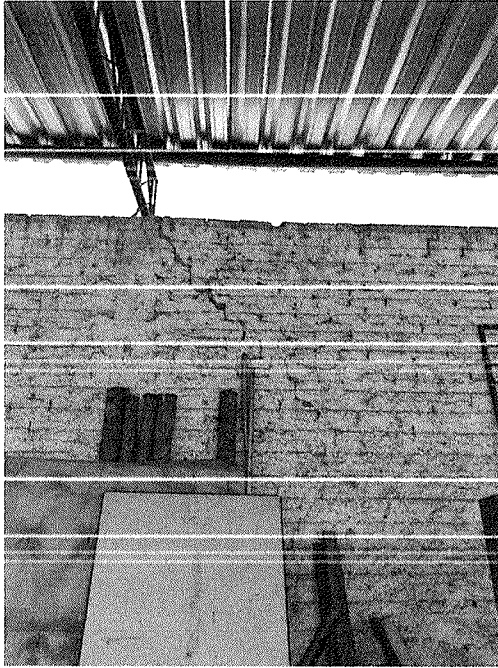
Figura 14 – Trinca.
