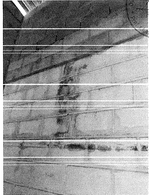
Figura 19 – Infiltração.
