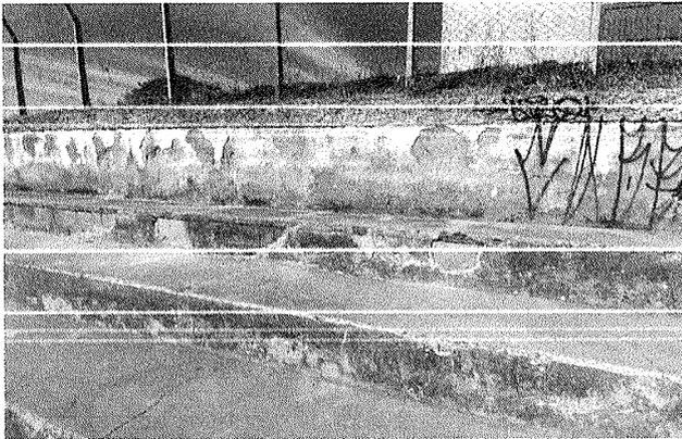
Figura 4 – Umidade e danos no acabamento.
