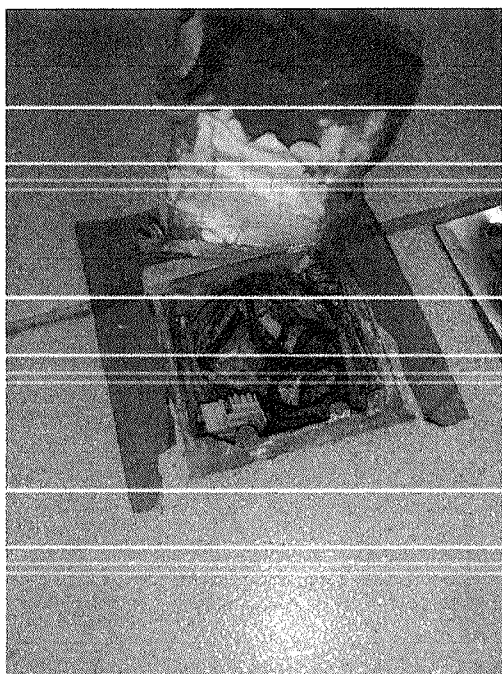
Figura 10 – Fiação exposta.
