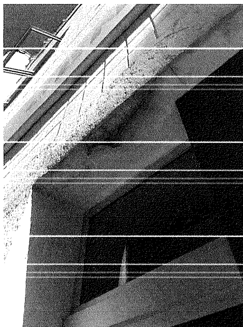
Figura 3 – Revestimento danificado.
