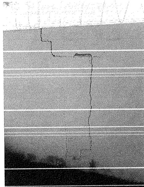
Figura 11 – Trinca no muro.
