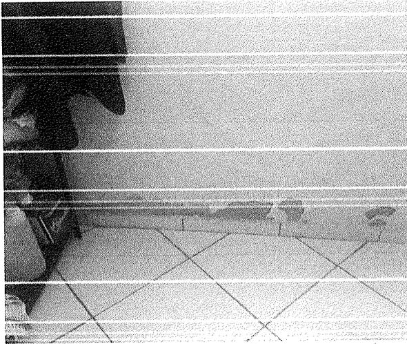
Figura 8 – Acabamento danificado na parede.
