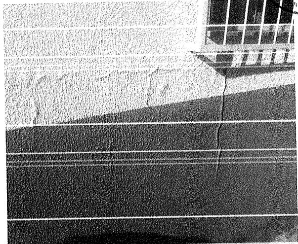
Figura 13 – Acabamento danificado devido a umidade.
