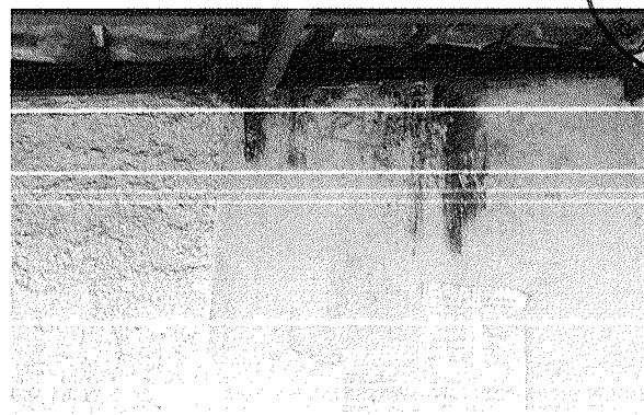
Figura 3 – Infiltração.
