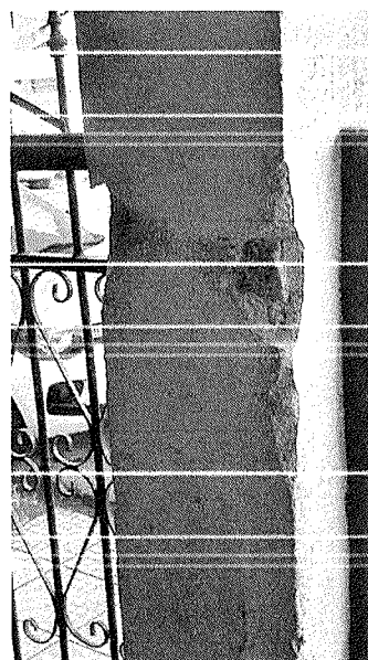
Figura 5 – Pilar danificado.
