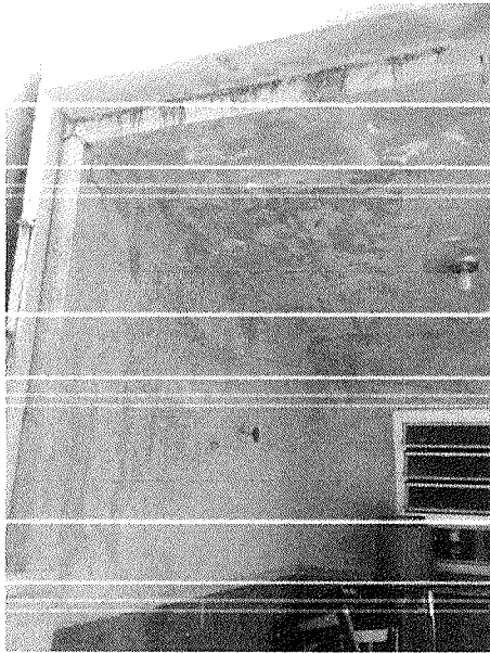
Figura 22 – Infiltração.
