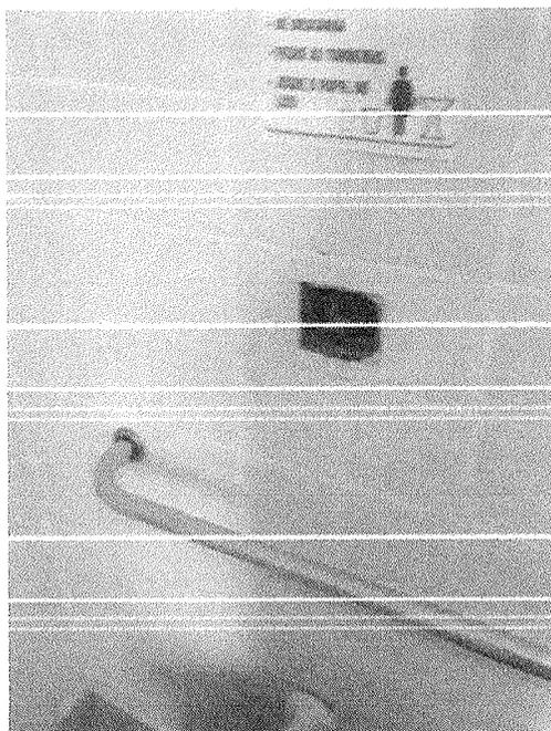
Figura 10 – Falta acabamento na válvula de descarga
