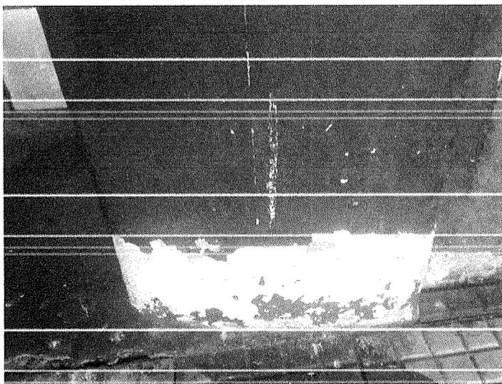
Figura 12 – Descascamento da pintura na área externa
