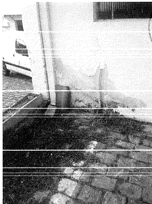
Figura 71 – Infiltração
