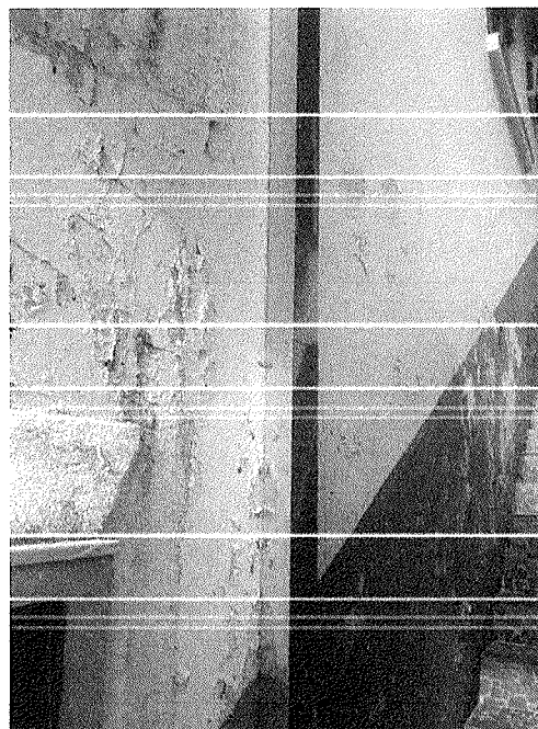
Figura 91 - Infiltração
