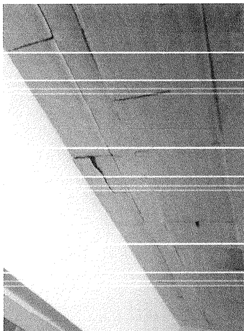
Figura 7 – Lajota danificada
