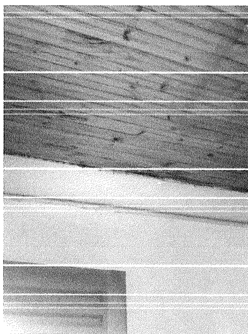
Figura 45 – Forro danificado
