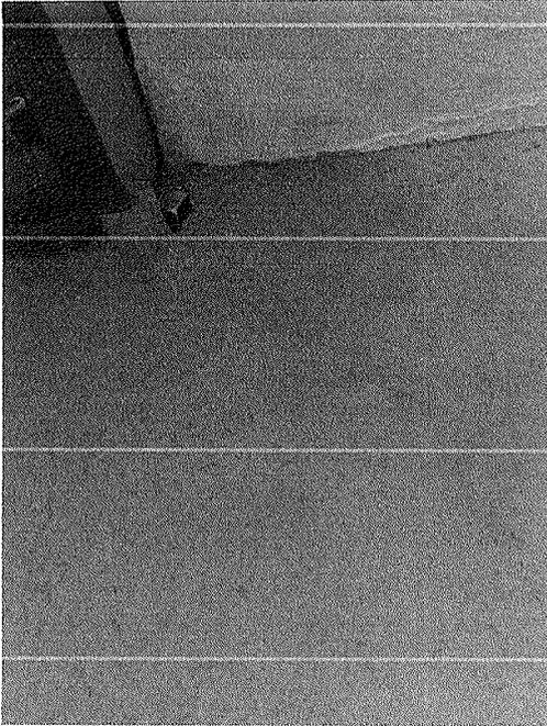
Figura 6 – Trinca 45° na parede do camarim
