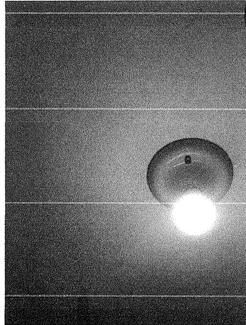
Figura 7 – Infiltração através do ponto de luz na sala do camarim
