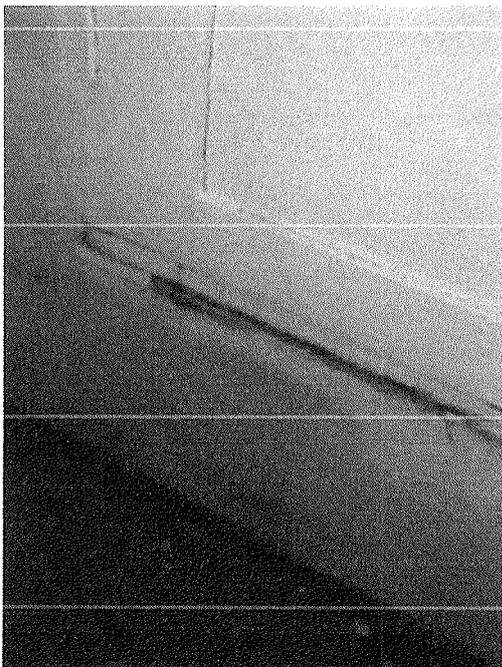
Figura 18 – Infiltração na janela lateral
