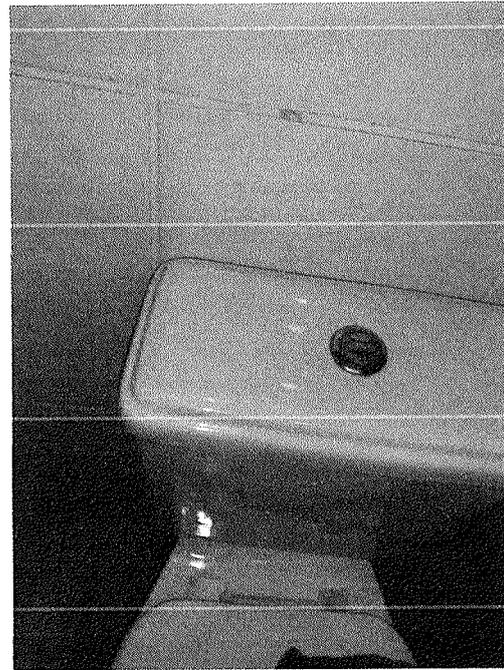
Figura 3 – Bacia sanitária com vazamento na caixa acoplada
