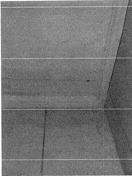
Figura 2 – Trinca no teto do banheiro feminino
