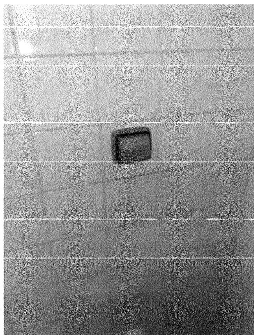
Figura 8 – Revestimento trincado
