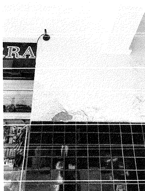
Figura 17 – Descascamento da pintura externa lado direito
