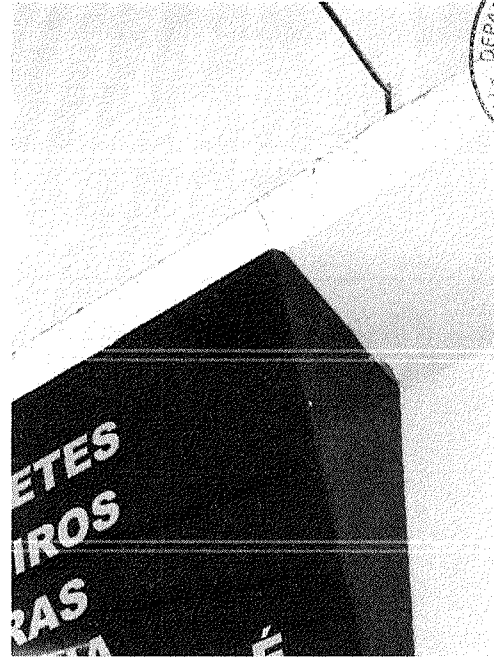
Figura 29 – Trinca no beiral externo das lojas
