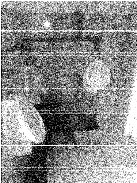
Figura 26 – Revestimento danificado
