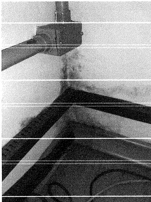
Figura 3 – Infiltração na parede
