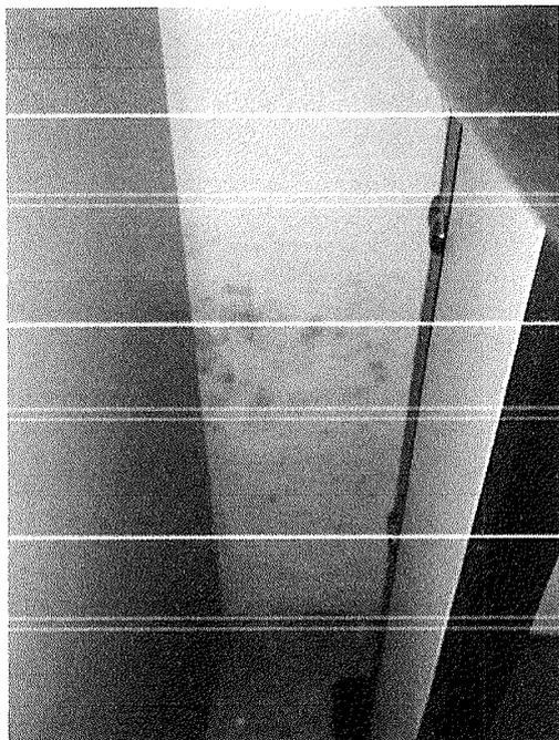
Figura 2 – Infiltração e descolamento da pintura
