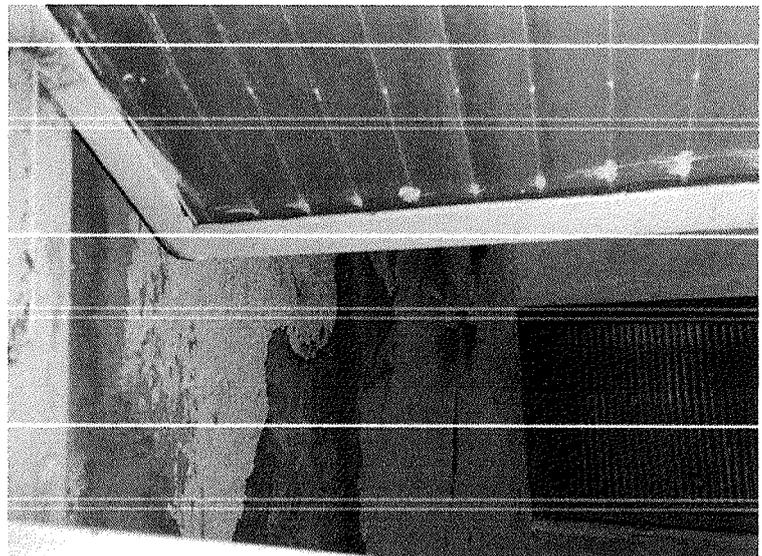
Figura 13 – Descascamento da parede
