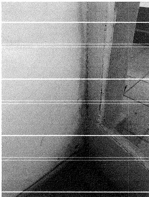
Figura 8 – Infiltração na janela
