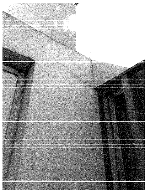
Figura 6 – Trinca na parede.
