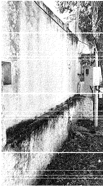
Figura 2 – Parede com umidade.
