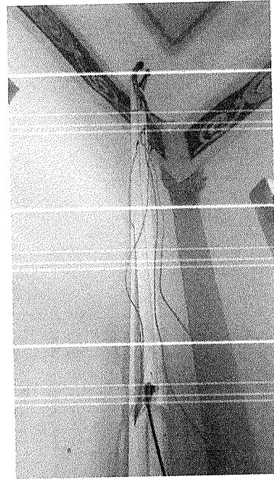
Figura 15 – Fiação exposta.
