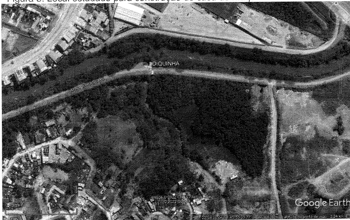
Figura 3: Local estudado para construção de casa de máquinas e bombeamento
