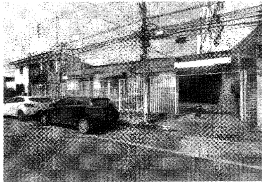
FACHADA PRINCIPAL DO IMÓVEL
