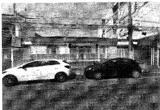
FACHADA PRINCIPAL DO IMÓVEL
